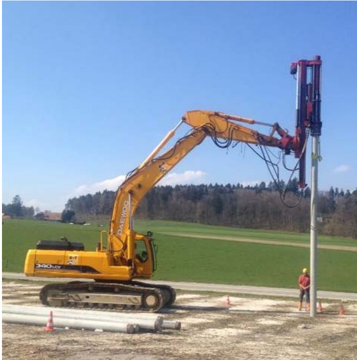
Bild: Grund- und Tiefbau AG
