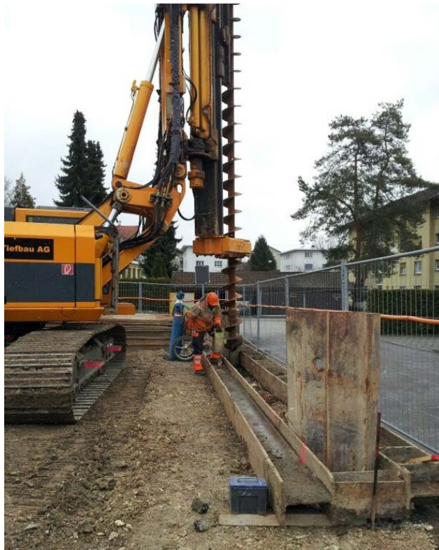
Bild: Grund- und Tiefbau AG
