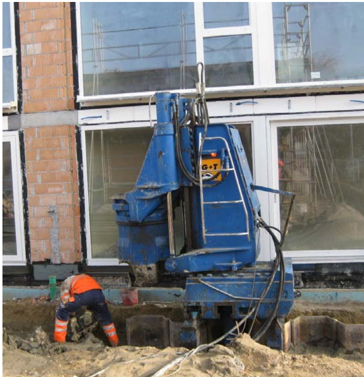
Bilder: Grund- und Tiefbau AG
