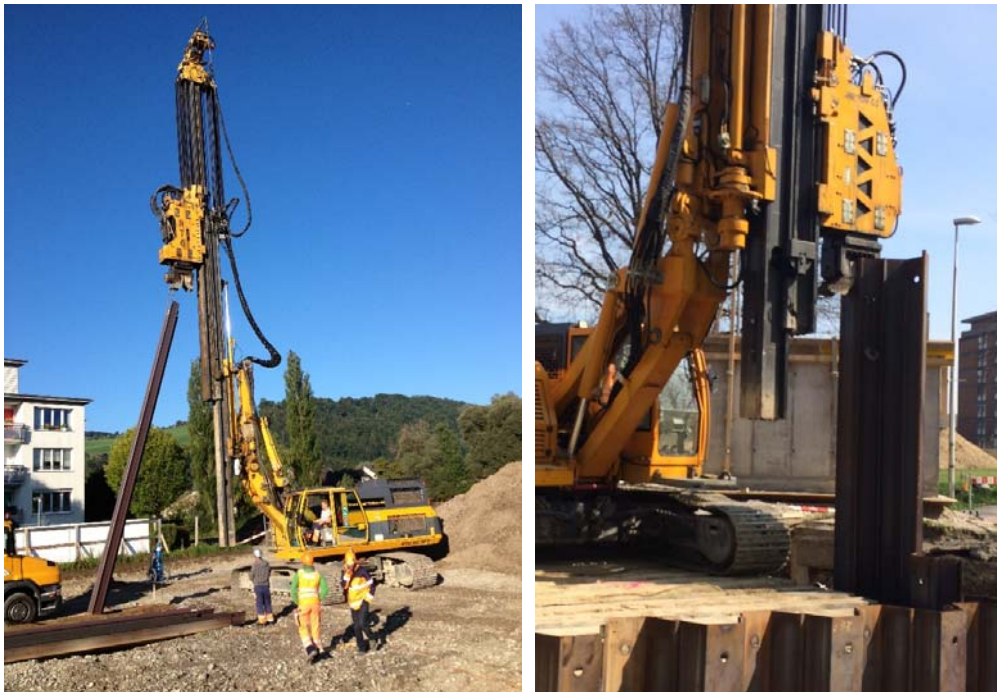
Bilder: Grund- und Tiefbau AG
