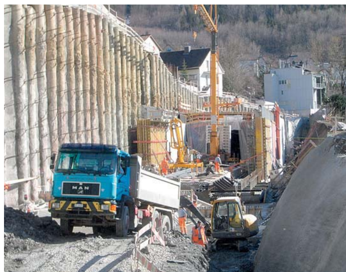
Grosse Geräte werden in der Baugrube Hangstrecke eingesetzt.
