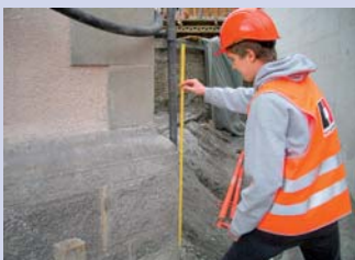
Genaueres Einmessen und Kontrollieren vor dem nächsten Arbeitsschritt.
