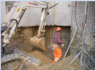
Pfahlausfachung im Bereich Deckelbauweise.
