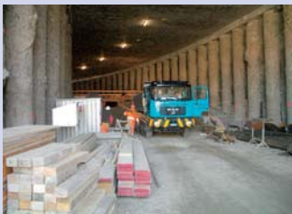
Innenansicht im Bereich Deckelbauweise.
