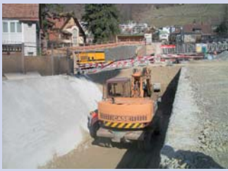
Hinterfüllungsarbeiten in der Flachstrecke.
